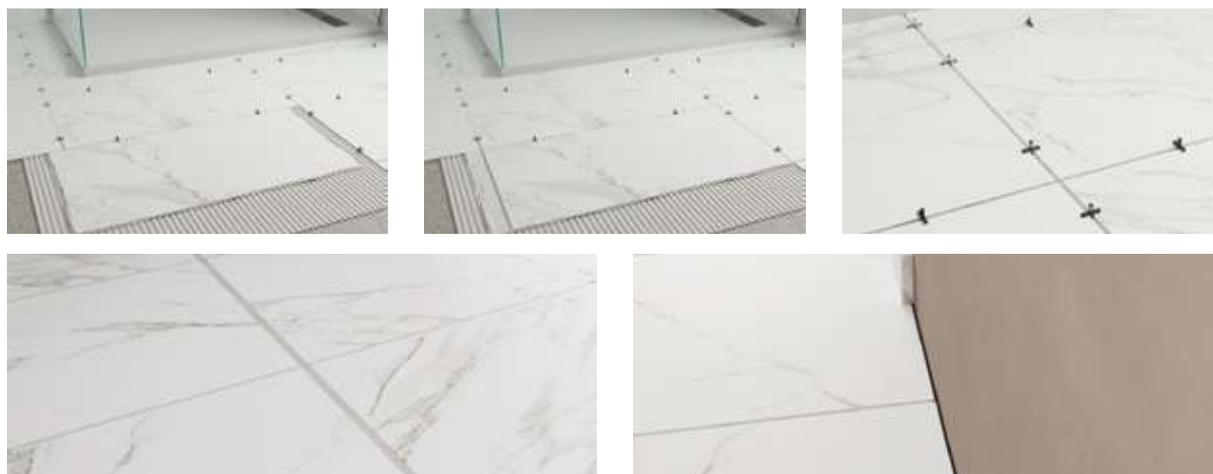
**4.3. JUNTAS DE COLOCACIÓN.** Siempre se debe respetar una junta mínima de colocación entre piezas según viene establecido en la tabla de selección de la anchura de la junta de colocación entre baldosas (Tabla 2), para ello se recomienda el uso de crucetas o cuñas, diseñadas para tal fin.
