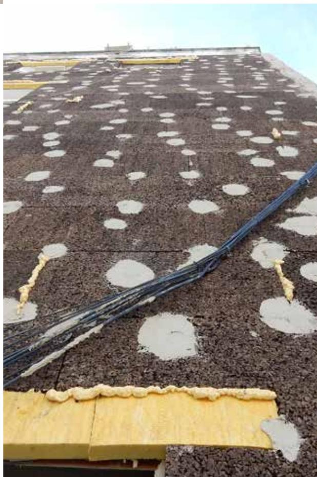
Soluciones constructivas para AISLAMIENTO TÉRMICO EXTERIOR (SATE)
