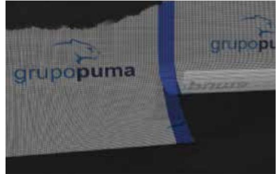
Presionar la Malla Traditerm con una llana sobre los surcos del mortero Traditerm / Traditerm Proyectable / Traditerm Flexible hasta que quede completamente embebida en el mismo. La malla aunque quede cubierta, deben marcarse las cuadrículas que la conforman. Esta capa ha de tener un espesor mínimo de 2 mm.
