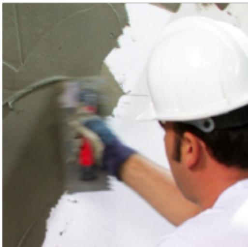
Posteriormente regularizar el espesor con una llana dentada del nº 8.
