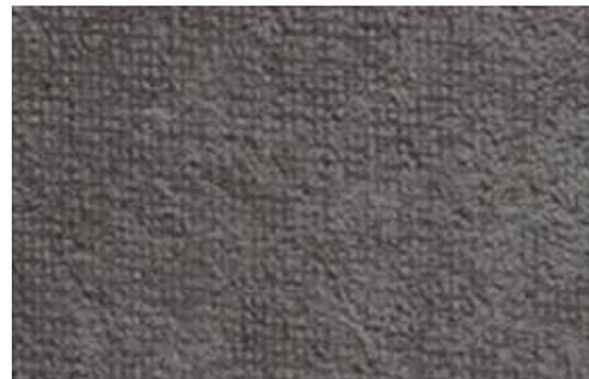
Una vez que esta capa alcance una cierta resistencia, normalmente 3-4 horas. después, se aplicará una segunda capa de mortero Traditerm / Traditerm Proyectable / Traditerm Flexible de 2 mm lisa pero no fratasada, que termina la superficie revestida. Para alcanzar el espesor deseado de esta segunda capa de mortero, se recomienda que ésta sea aplicada con la ayuda de una llana dentada del nº 8.
