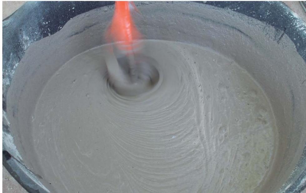
Le temps de gâchage est environ de deux minutes, jusqu'à obtenir un mélange homogène et sans grumeaux. Il est conseillé de toujours mélanger des sacs complets en une seule fois. La dose exacte d'eau (qui est indiquée sur la fiche technique) ou sur le sac est très importante afin d'éviter la ségrégation du produit, d'importants rétrécissements et une diminution des propriétés mécaniques. Il faudra laisser le mélange reposer encore deux minutes avant de sa mise en service.
