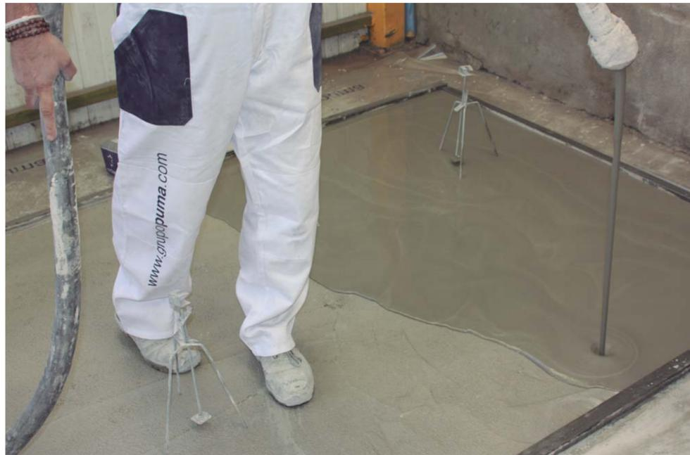
Étendre manuellement avec une truelle métallique pour le nivellement et passer un rouleau à pointes en nylon, de la taille appropriée à l'épaisseur du produit autolissant, afin d'éliminer l'air occlus qui pourrait apparaître pendant le processus de mélange.
