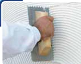
**2** Una vez fraguado el MORCEMDRY, aplicar PEGOLAND FLEX o PEGOLAND ESPECIAL (según el grado de absorción de la pieza cerámica) peinándolo con una llana dentada.
