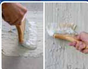
**1** Amasar con consistencia de lechada y aplicar una primera capa espesa de MORCEMDRY. Dejar secar de 2 a 4 horas aprox. Aplicar una segunda capa en sentido perpendicular a la primera.
